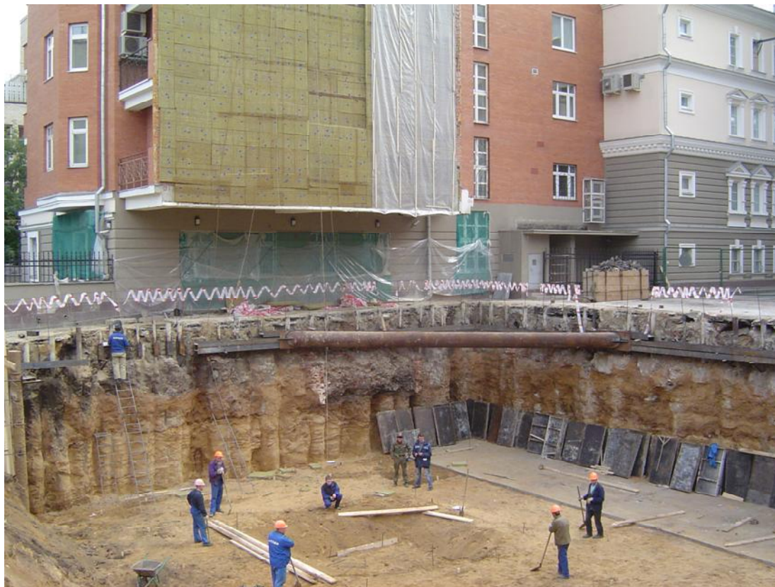
Рис. 5 Пример устройства ограждающей конструкции из грунтоцементных свай
